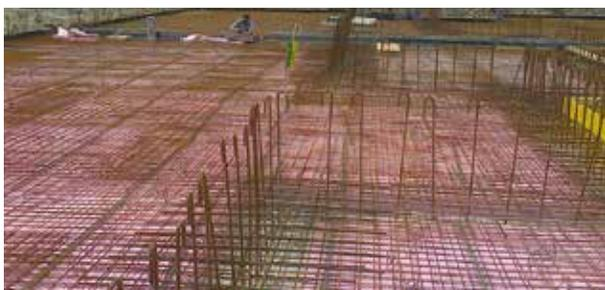
Beim **Neubau** ist es wichtig, schon vor der Fundamentierung des Hauses das Erdungssystem zu planen und die Erdleitungen richtig zu verlegen! Vor allem wenn die Fundamentplatte isoliert gegen Erde errichtet wird, ist der zusätzliche Einbau von einem Anlagenerder von großer Bedeutung, um sicherzustellen, dass der Blitzstrom rasch ins Erdreich abfließen kann.
