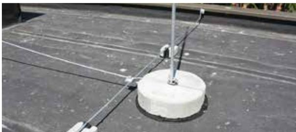
Der **Äußere Blitzschutz** schützt ein Gebäude, indem die Fangeinrichtungen die direkten Blitzeinschläge aufnehmen und den Blitzstrom über sog. Ableitungen in die Erdungsanlage weiter ins Erdreich ableiten - ohne Gefahr für Personen und Haus.
