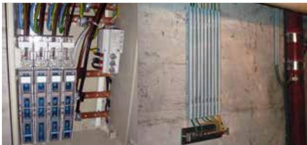
**Hohe Überspannungen** sind eine häufig unterschätzte Gefahr! Gründe hierfür sind oft nahe, aber auch ferne Blitzschläge oder Spannungstöße im Versorgungsnetz. Folgen sind brandauslösende Zündfunken an Klemmstellen, zerstörte Elektronikteile und eine defekte Haustechnik. Zur Abwehr ist der Einbau von Überspannungsableitern in ihrem Verteiler nötig.
